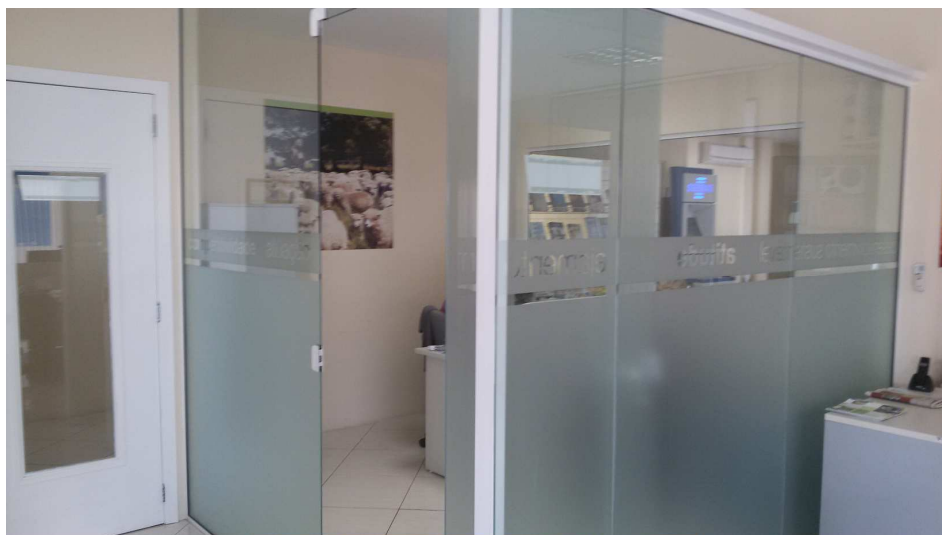
Foto 1 – Divisórias leves em vidro a serem removidas e realocadas
